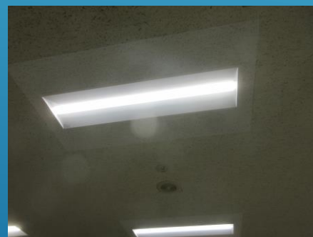
照明設備のLED化
