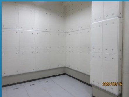
耐震壁の新設
