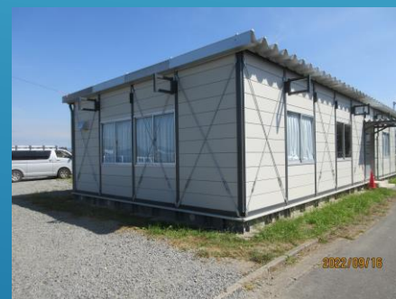
仮設事務所設置
