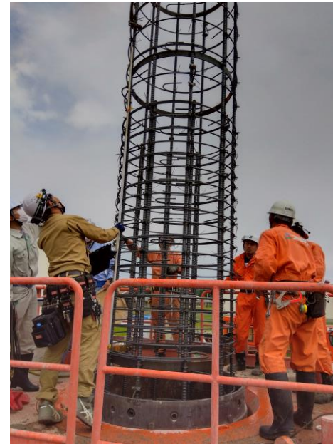
鉄筋かご 建込み
