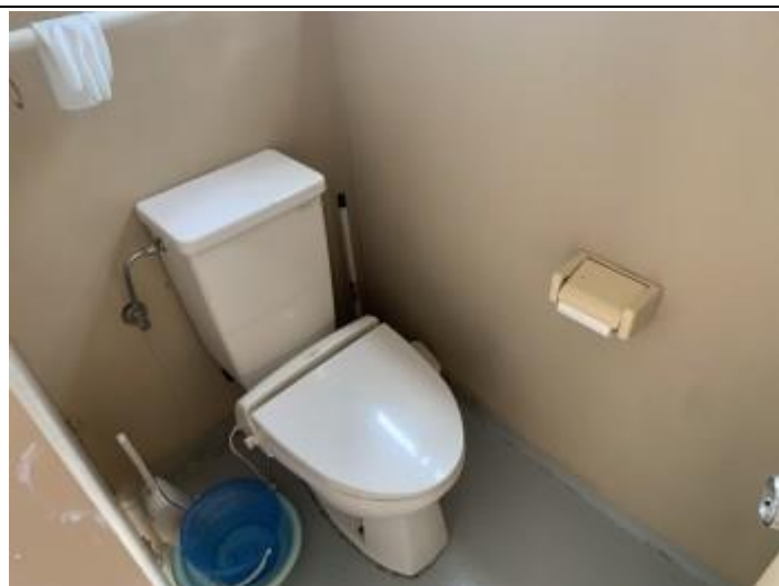
08 建物① トイレ3
