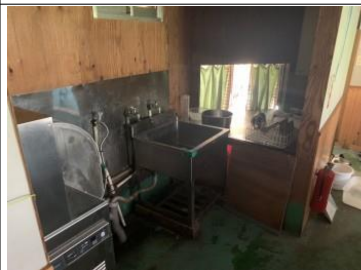
16 建物② 調理室2
