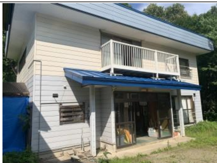
10 建物② 外観1
