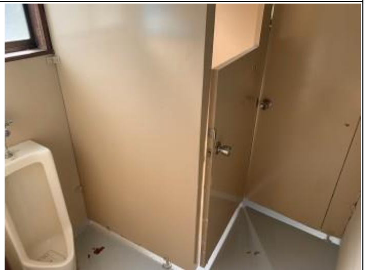
06 建物① トイレ 1
