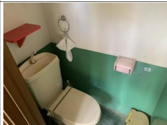
18 建物② 1階トイレ2
