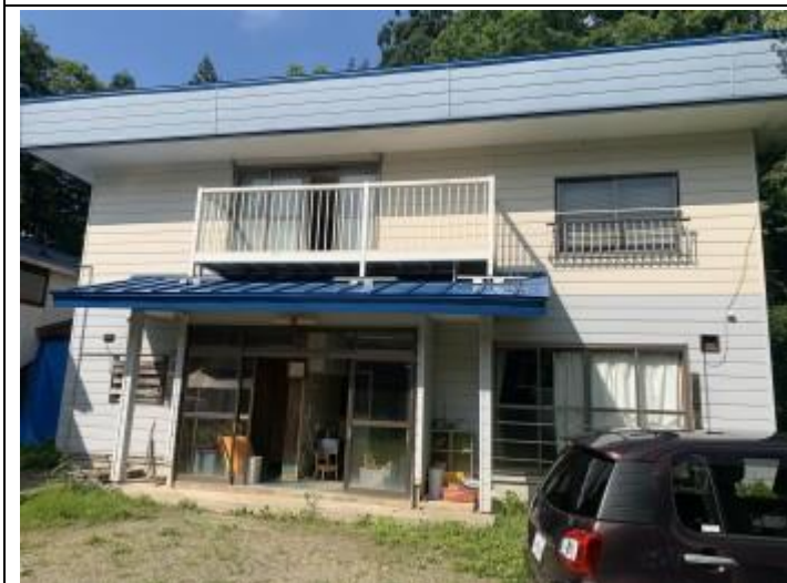
11 建物② 外観2
