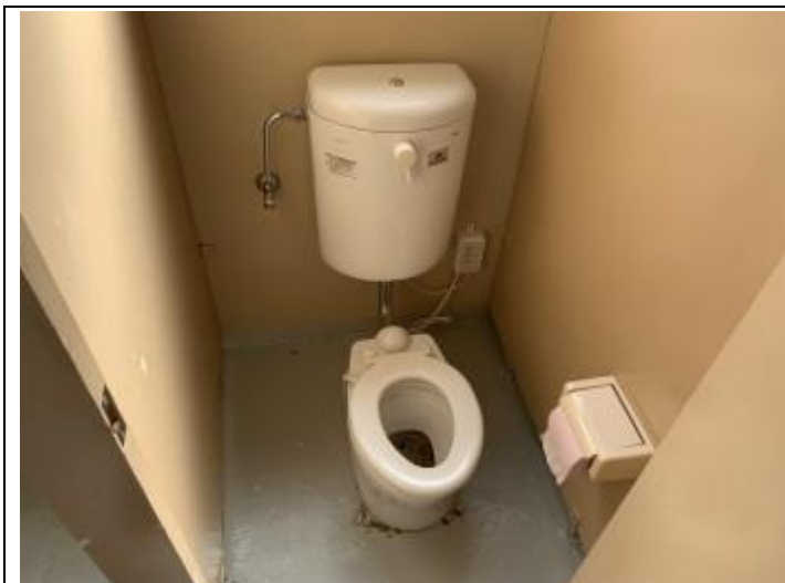
07 建物① トイレ2
