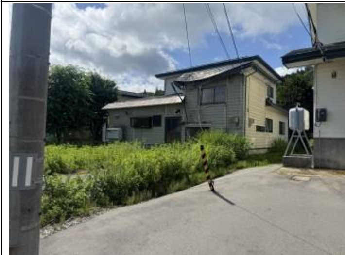
03 外観（北西→南東）
