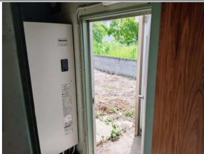
25 1 階ボイラー室外扉
