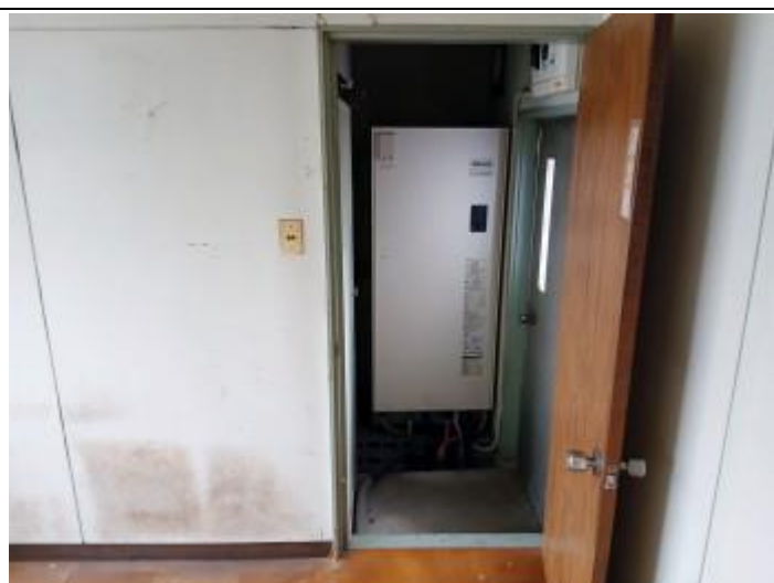
24 1 階ボイラー室
