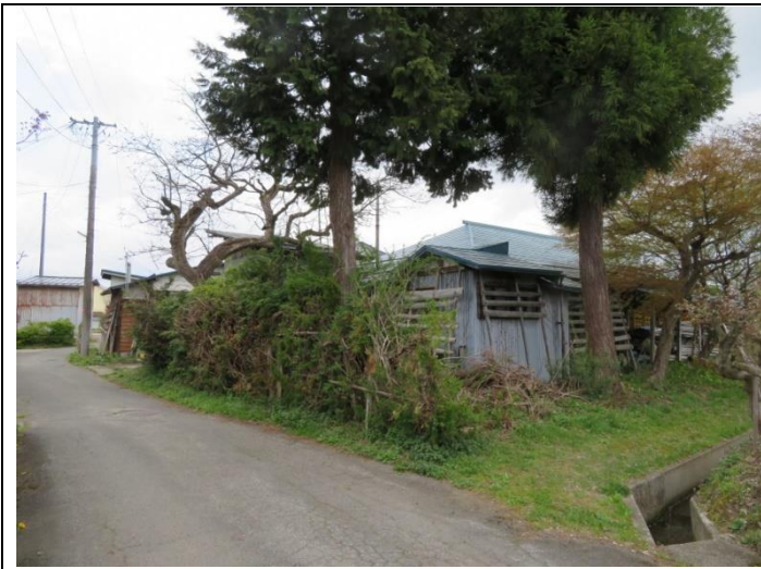
01 前面道路と敷地（北西→南東）
