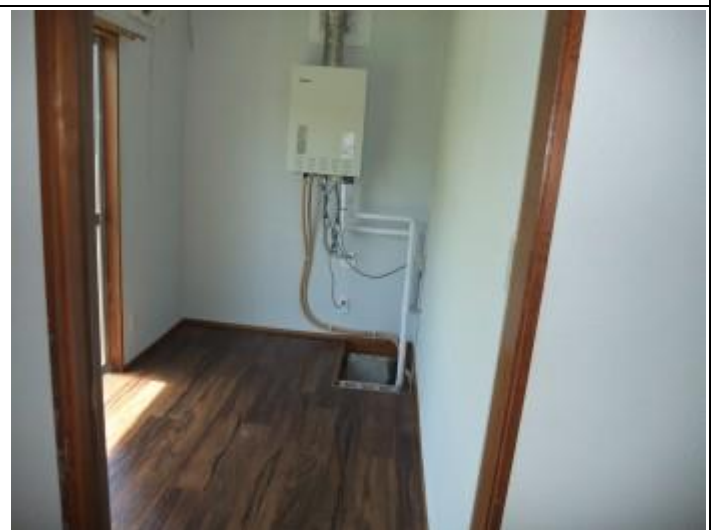
10 物置ボイラー室
