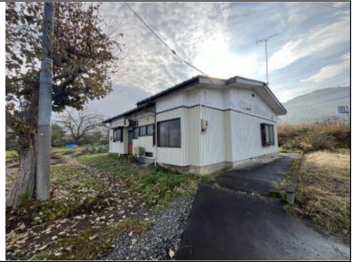
02 外観（北西から）
