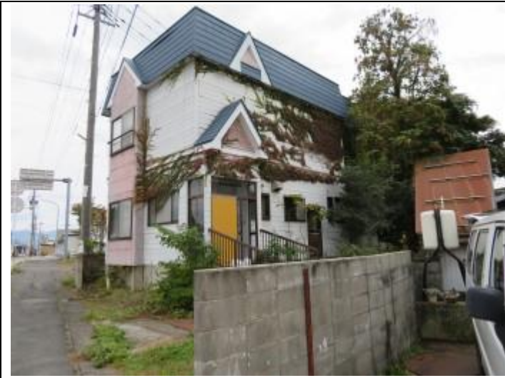
01 外観（北西→南東）
