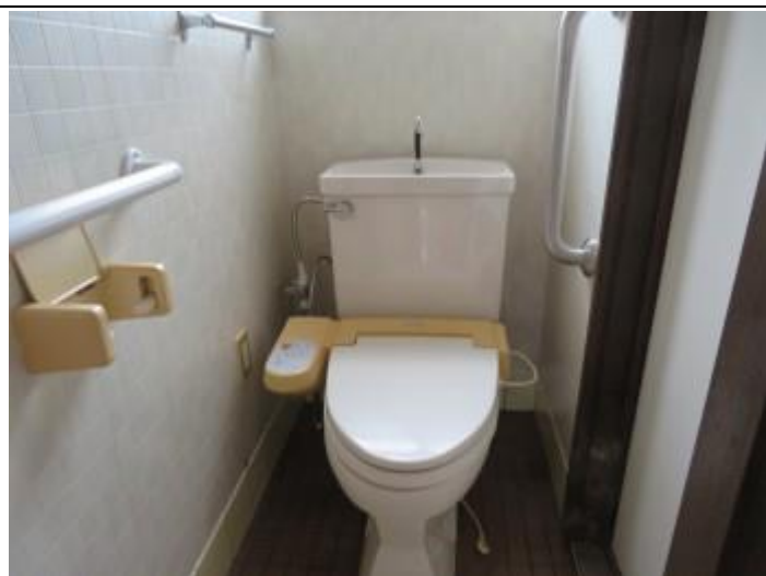
10 トイレ（玄関側）
