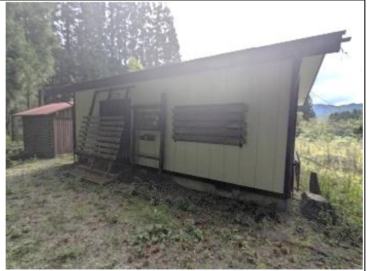
02 主屋外観（北面）
