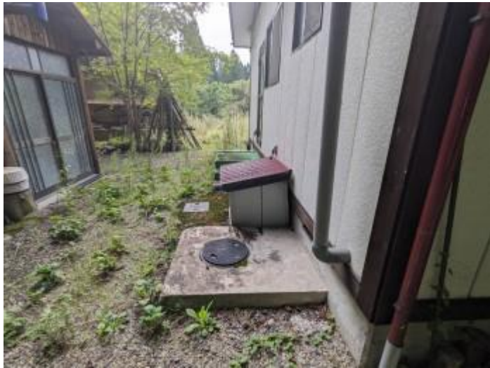
03 主屋外観（東面）
