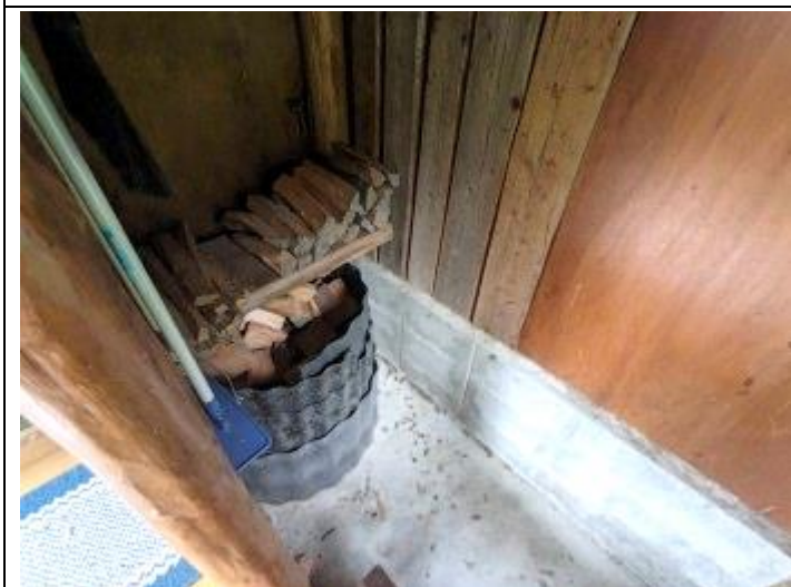
15 風呂棟（ボイラー）（薪）
