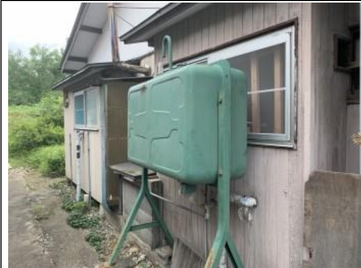
03 外観（北側①）
