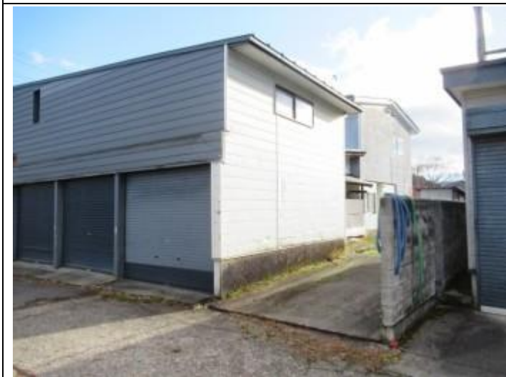
05 車庫（北西より）
