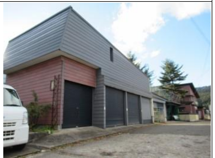
06 車庫（北東より）
