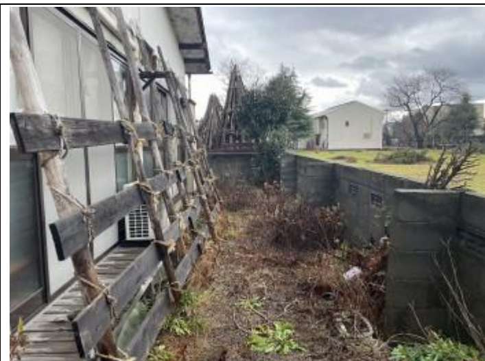
08 南側境界ブロック
