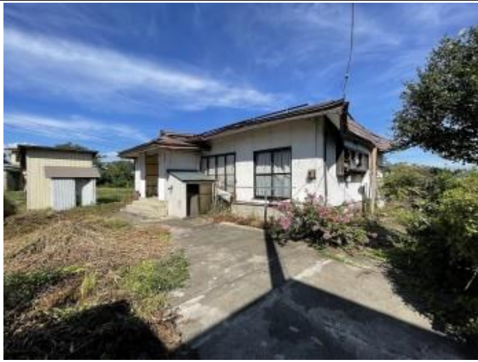
01 敷地（南東から）
