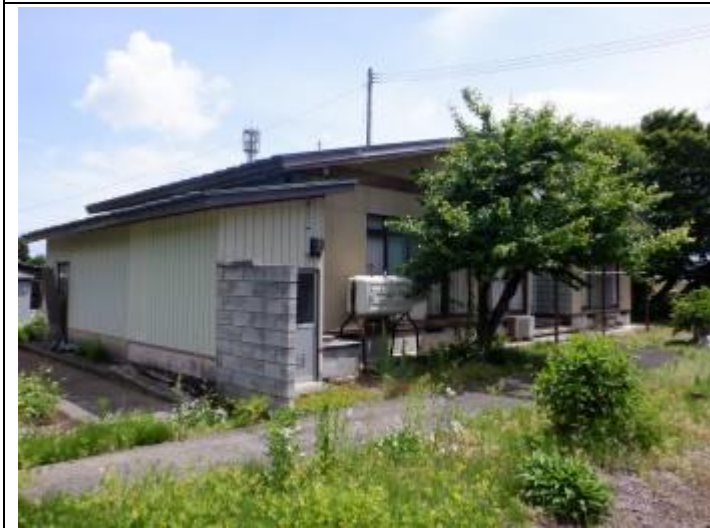
03 外観（南西から）
