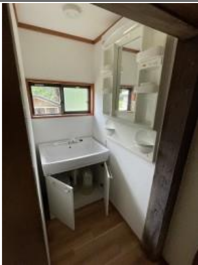
21 洗面台 (トイレ隣)
