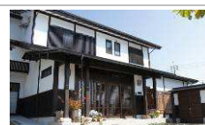
※[木部表しの庇の例] 木の構成を隠さずそのまま表して見せること。
