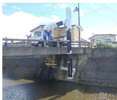
(b) 橋梁点検車を用いた定期点検
