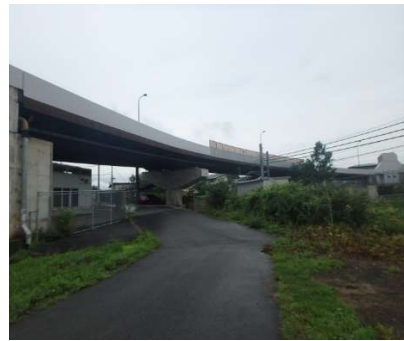
跨線橋（鉄道を跨ぐ橋梁）の例
