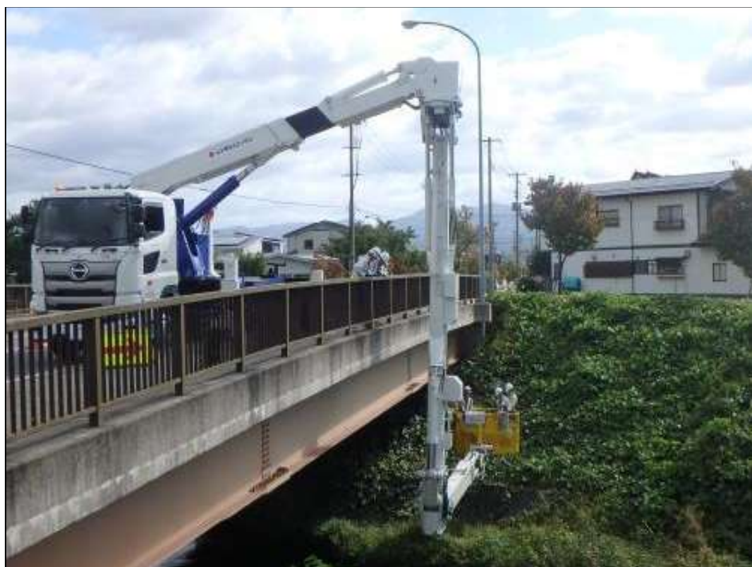
橋梁点検車を用いた定期点検の実施状況（写真：榎橋）
