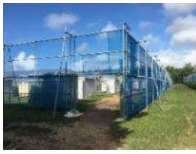
防風ネットの設置
