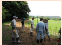
侵入防止柵の設置
