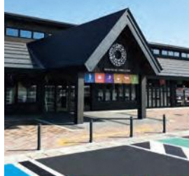
問：道の駅 米沢 (総合観光案内所)
