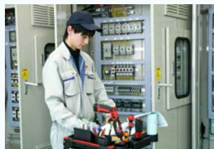
完成した制御盤の検査を行う今井さん
