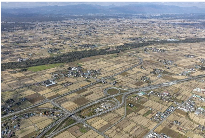
(写真：米沢北インターチェンジ周辺)
