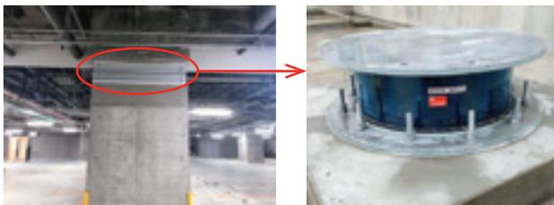
地震による振動エネルギー（揺れ）を直接建物に伝えないように考えられたのが免震構法です。
