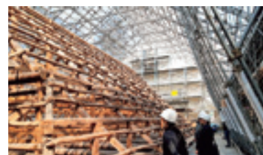
普門院解体修理 (屋根部分梁の様子)
