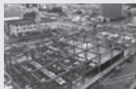
▲建設中の新庁舎
